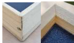
Abbildung 5: Gehrungsschnitt und Regenkante
